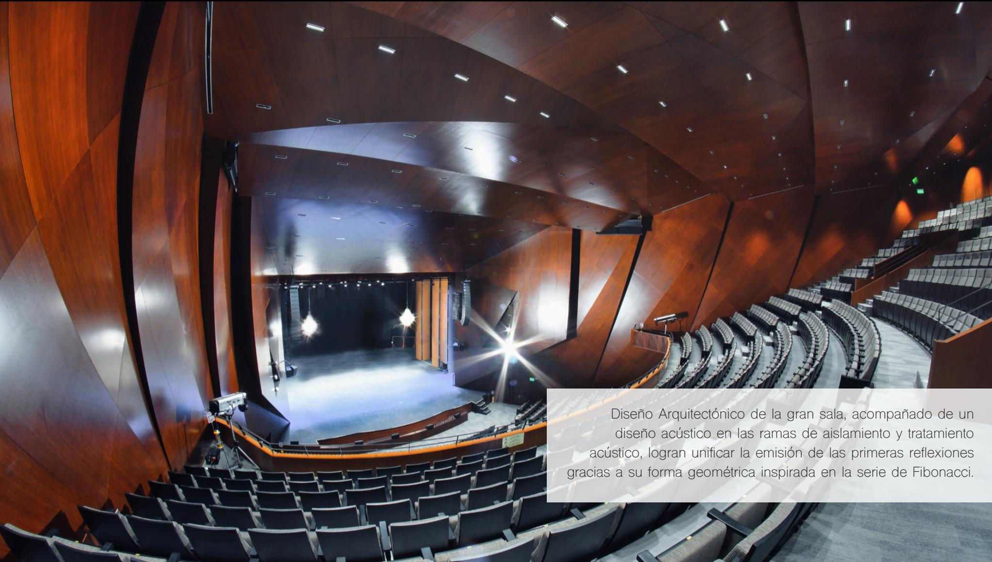
Diseño Arquitectónico de la gran sala, acompañado de un diseño acústico en las ramas de aislamiento y tratamiento acústico, logran unificar la emisión de las primeras reflexiones gracias a su forma geométrica inspirada en la serie de Fibonacci.
